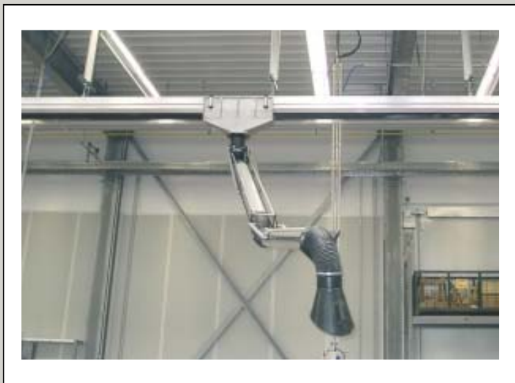
Система удаления отработанных газов на базе канала-воздуховода SSK290 со всасывающим рукавом диаметром 160 мм (длина 4 м) – для удаления сварочных газов в кузовном цехе
