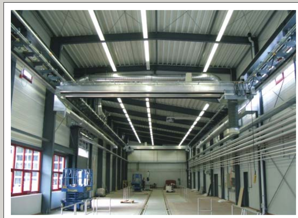
Система удаления отработанных газов для локомотивов с тремя степенями свободы, построенная на базе канала-воздуховода SSK 450 / SSK 900. Зона охвата системы 12x60 м. Система установлена под путями для мостового крана; предусмотрена система блокировки по условиям безопасности. Управление системой удаления отработанных газов ручное или при помощи пульта ДУ. Производительность системы до 20,000 м 3 /ч
