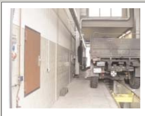
Система на основе канала-воздуховода SSK 150 для удаления отработанных газов на универсальной диагностической линии с вентилятором FD. Опция: автоматический тросиковый возврат каретки в исходное положение и автосброс насадки с трубы глушителя
