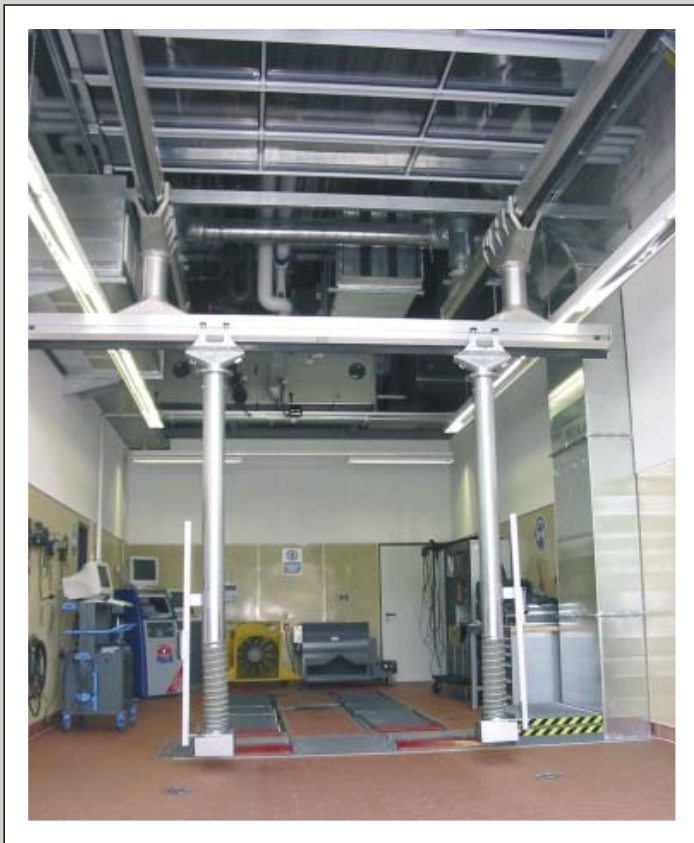
Система удаления отработанных газов, собранная на базе системы каналов SSK 290, для легкового полноприводного мощного стенда. Производительность до 4,000 м 3 /ч, температурный режим до 900°C
