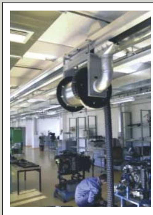
Вытяжная катушка с пружинно-возвратным механизмом,двигающаяся по каналу-воздуховоду SSK 290
