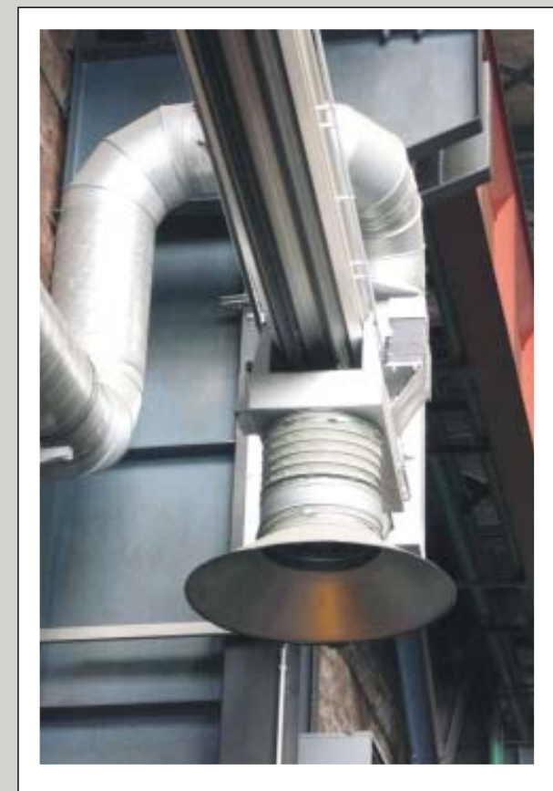
Система удаления отработанных газов SSK 900 с поворотным раздвижным рычагом и внутренней подвижной газоприемной насадкой диаметром 450 мм для удаления до 10.000 м 3 /ч газов с электроприводом. Движение по трем координатам. Возможно управление при помощи радиопульта ДУ
