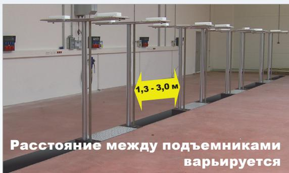
Подъемники могут быть установлены в любое требуемое положение внутри канала. Таким образом, расстояние между подъемниками варьируется от 1,3 до 3,0 м.
