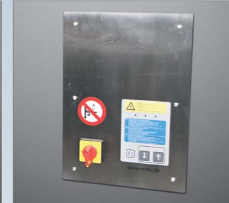
Schaltkasten unterputz montiert (Option)
